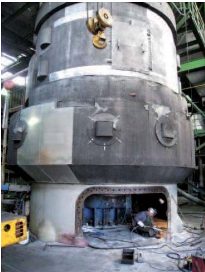
▲ Bild 5. Durch die stetigen hohen Belastungen während des Betriebs dieser Kugelmühle traten Risse im Mannlochbereich auf.
